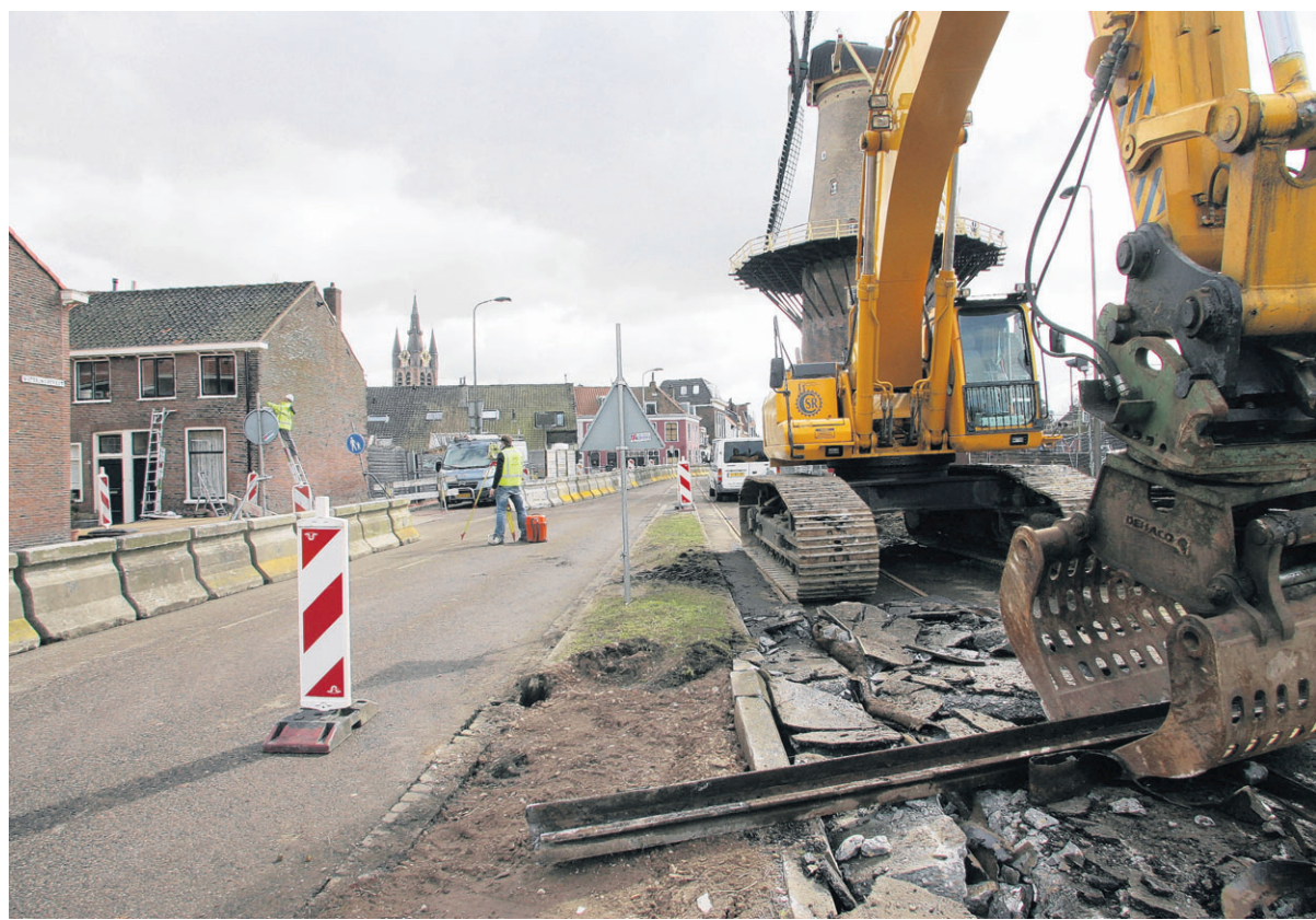
Schade-experts verrichten metingen aan woningen in de Dirklangendwarstraat. FOTO REMCO SUIKER
